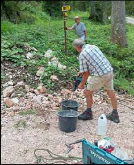
Wegweiser am Moosensteig versetzt und mit Betonsockel fixiert
