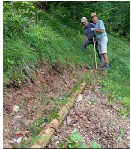
Steg am Moosensteig erneuert
